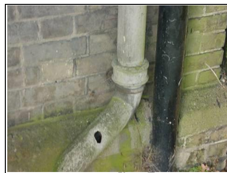
Asbestos pipe
