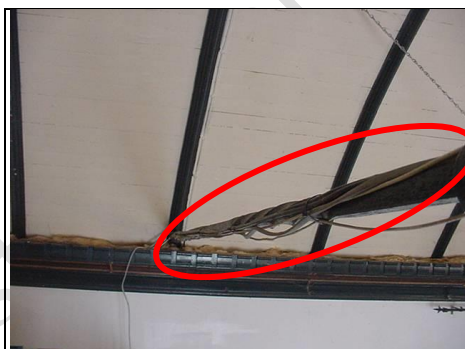
Horizontal tie bar
