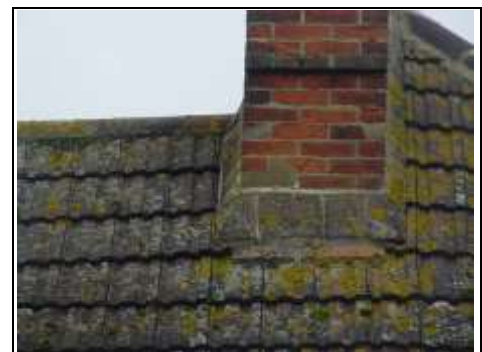
Tile on edge flashing
