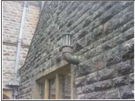
Asbestos flue
